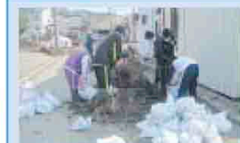
石巻瓦礫撤去作業の様子
